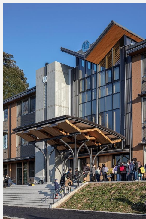
昇降口前の大庇（CLT製）
