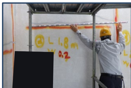
外壁クラック補修
