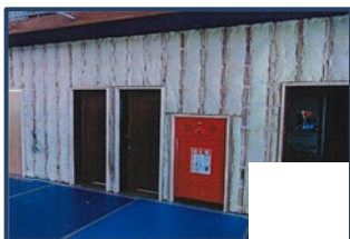
断熱材充填作業
