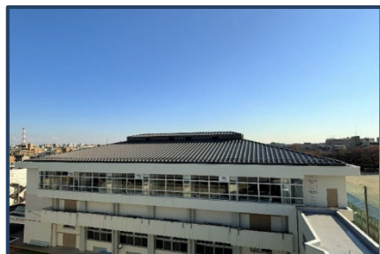
施工後・屋根遠景
