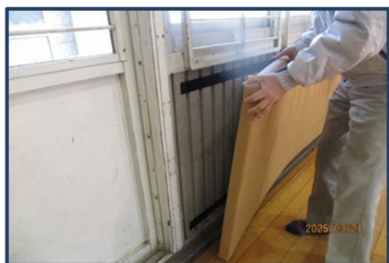
マジックテープによる防護マット取付
