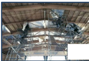
遮熱シート貼付
