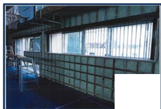
横胴縁取付作業
