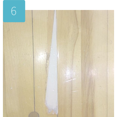
6 補修テープを貼って 修繕完了
