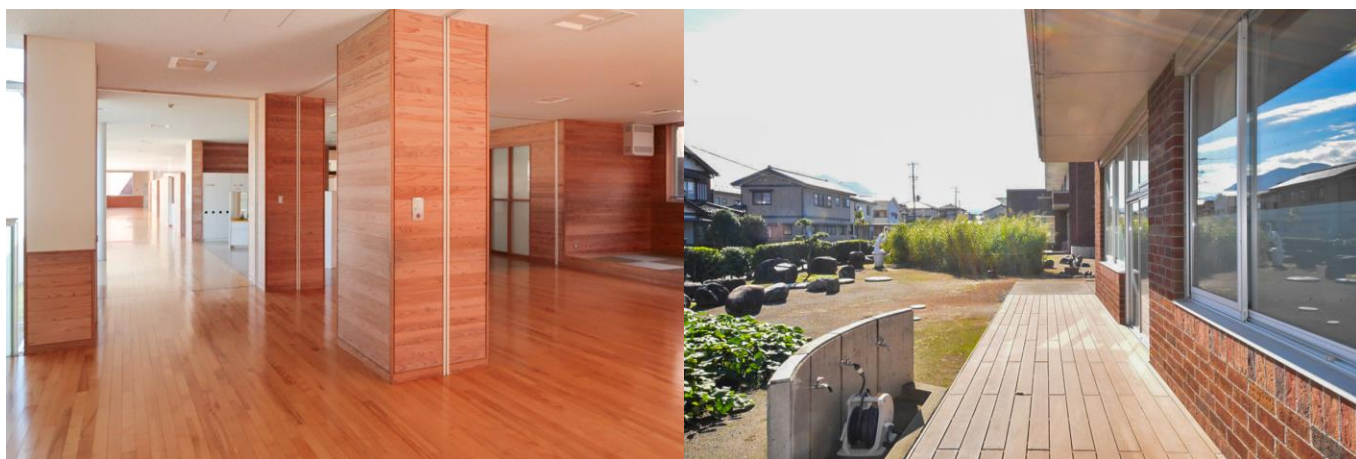
県産の木材を積極的に利用し、ぬくもりのある空間に（左） ひすいの里総合学校の屋外デッキと学校畑。雨水貯留槽を備え、ビオトープや非常時のトイレに利用（右）
