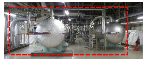
高圧第1、2給水加熱器（解体前）
