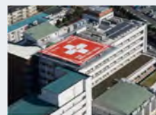
屋上ヘリポート
