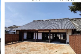
萩市による保存修理
