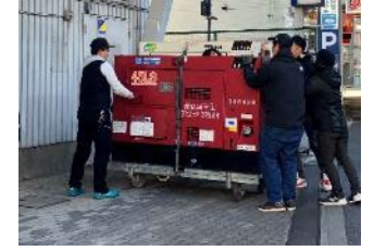
* 会場外に外部供給用発電機設置
