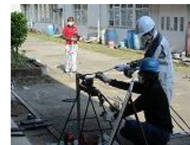
ガス圧接工事
