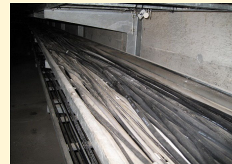
敷設後51年が経過し、老朽化が 進んだ基幹電力線
