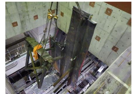
※：蒸気タービンの据付位置からの撤去について計画どおり完了。一部の大型の解体物はT/B内に保管し、次年度以降に細断して所外搬出予定。
