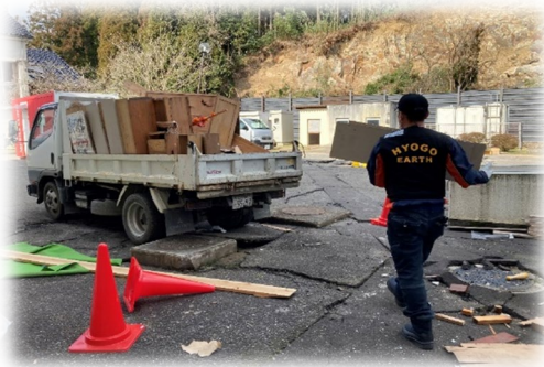
正院小学校 がれき処理
