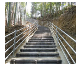
避難路の整備
