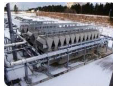
フュージョンインフォマティクス用計算機冷却設備
