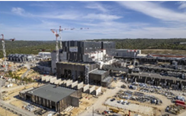
ITERサイトの建設状況
