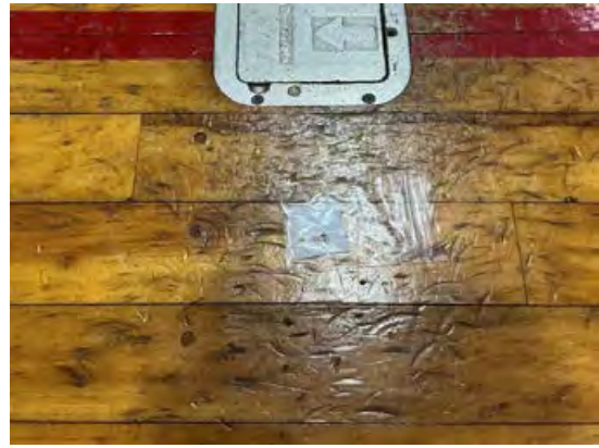
バレーボール支柱の仮置き等で傷ついた床板
