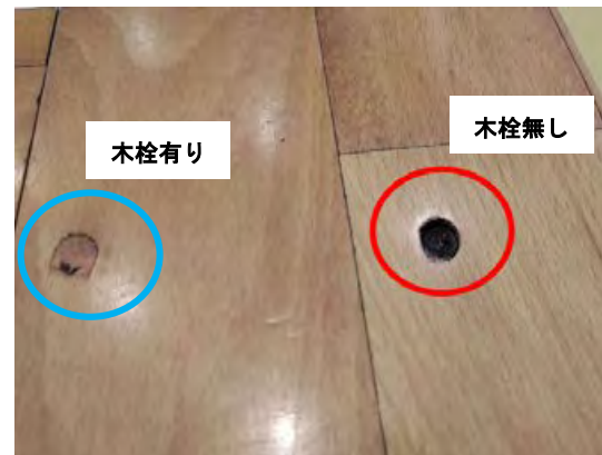
正常な木栓及び 木栓が紛失して露出したねじ頭
