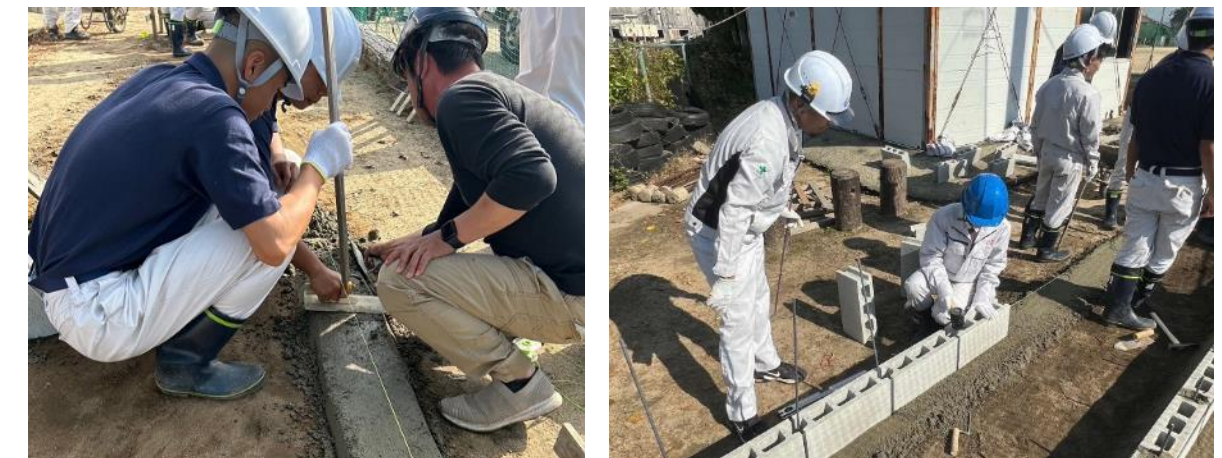
校内特別実習で野球場ベンチ部分のコンクリート打ちをしている様子
