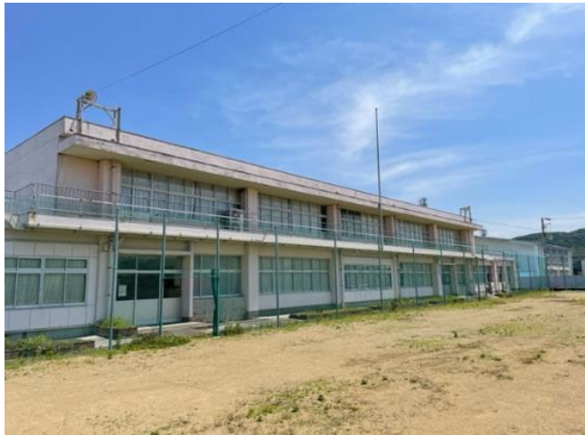
校舎等の外観写真
