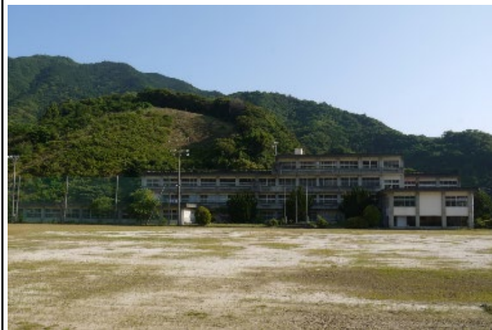
校舎等の外観写真
