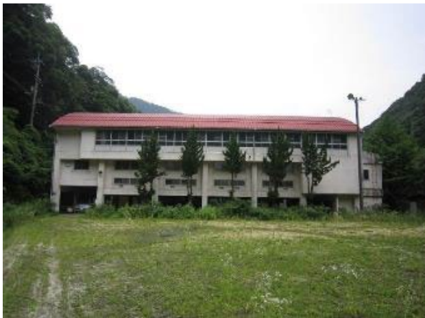
校舎等の外観写真
