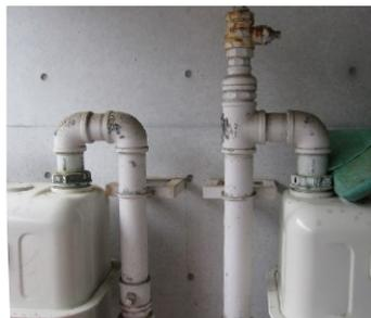
都市ガスエリアにおいても災害時にLPガスを使用できるよう変換機の接続口を整備
