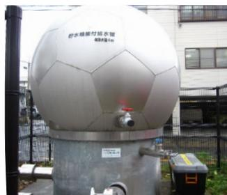
平時は給水管として使用し、断水時は貯水した水が使用できる貯水機能付給水管を設置
