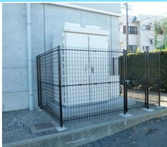
停電時に電源を供給するための蓄電池システム
