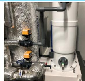
飲料水確保のため雨水の浄化装置を設置
