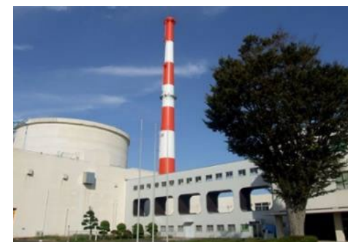
高速実験炉「常陽」
