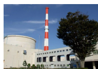
高速実験炉「常陽」
