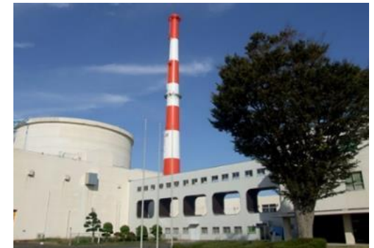
高速実験炉「常陽」
