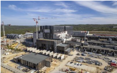
ITERサイトの建設状況
