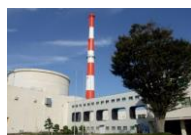
高速実験炉「常陽」
