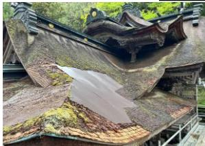
檜皮葺屋根の経年毀損（金属板にて応急処置）
