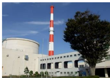
高速実験炉「常陽」
