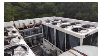
理化学研究所の空冷式チラーの更新
