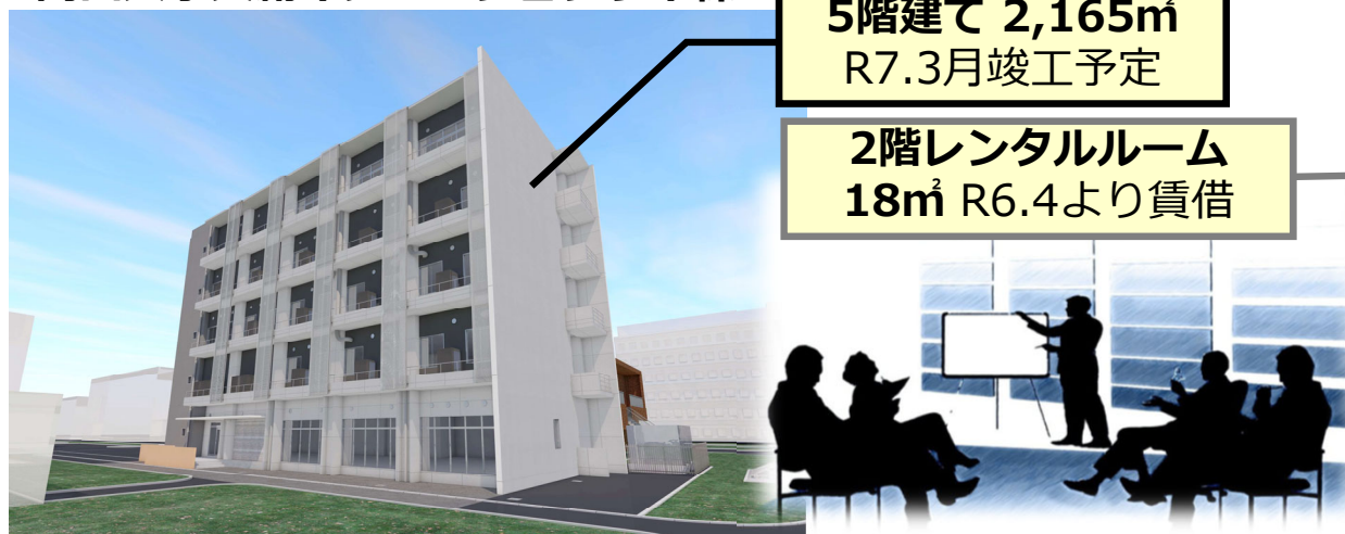
岡山大学共創イノベーションラボ棟
