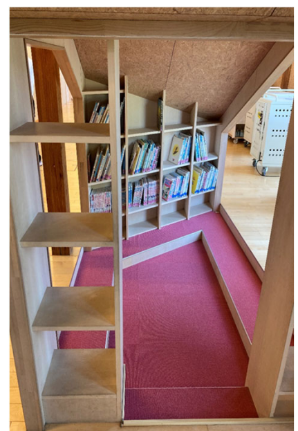
階段の下の空間に造り付けられた棚と腰掛部
