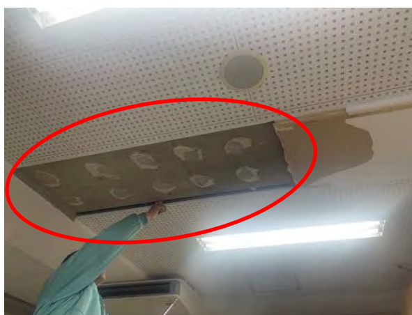
梁下に天井ボードが直張りされていた箇所
