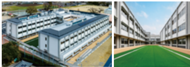
【新築された校舎：みどりの杜木城学園】
