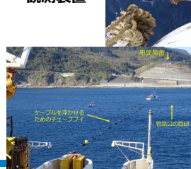
ケーブル陸揚げ作業 (宮崎県串間市)
