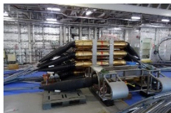
敷設船内に格納されたN-net観測装置
