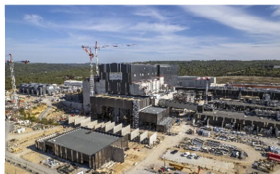
ITERサイトの建設状況
