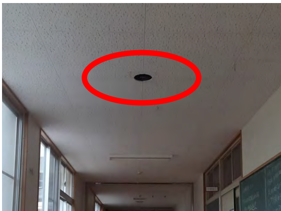
スピーカーが設置されていた天井
