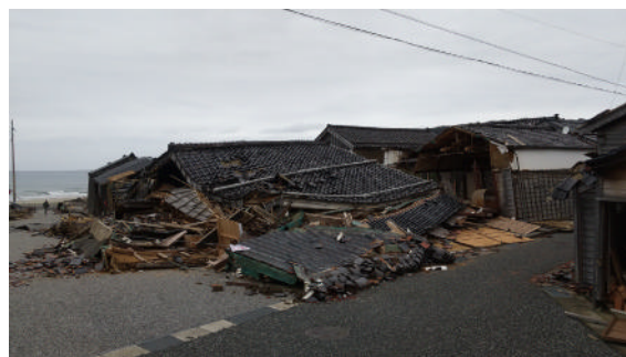
倒壊した旧角海家住宅
