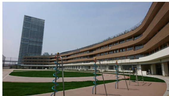
木材の活用により快適で健やかな環境を生み出し、脱炭素化社会の実現に貢献 (東京都 江東区立有明西学園)
