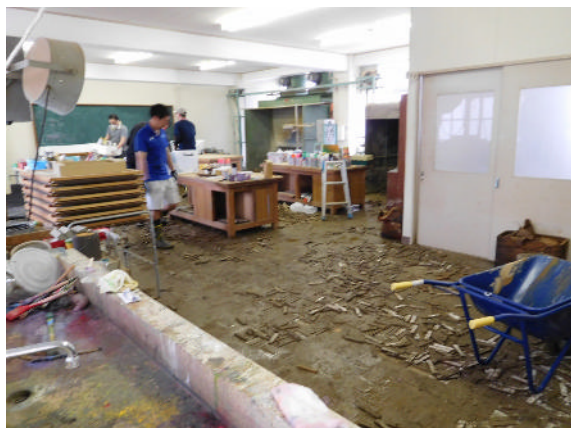
令和5年5月からの梅雨前線豪雨で生じた床上浸水被害
