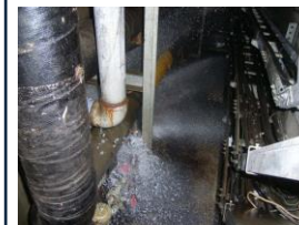
配管の破損による 水漏れ
