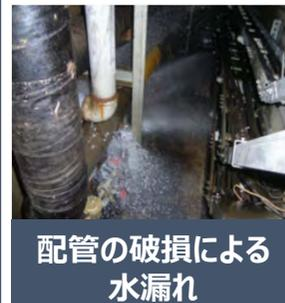
配管の破損による
