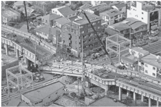
資料 6 地震によって倒壊した新幹線高架橋
