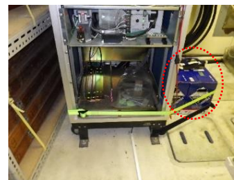
外付けで応急的にバッテリーを仮設
