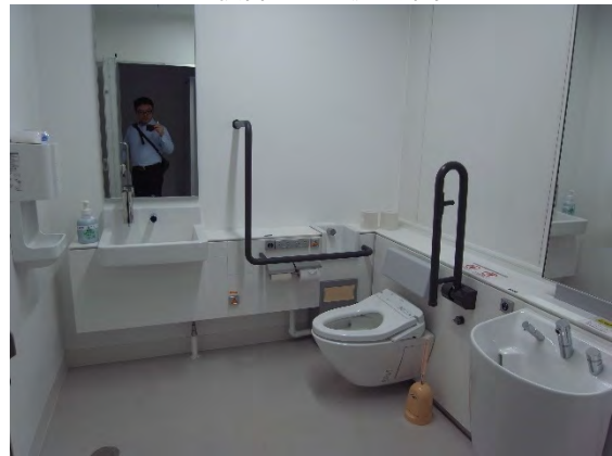
改修したトイレ
