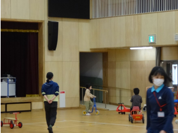
体育館の舞台上がるためのスロープ
