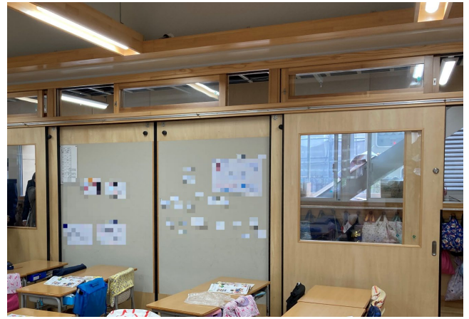
普通教室・教室周りの機能向上 (掲示板付きの間仕切り)
