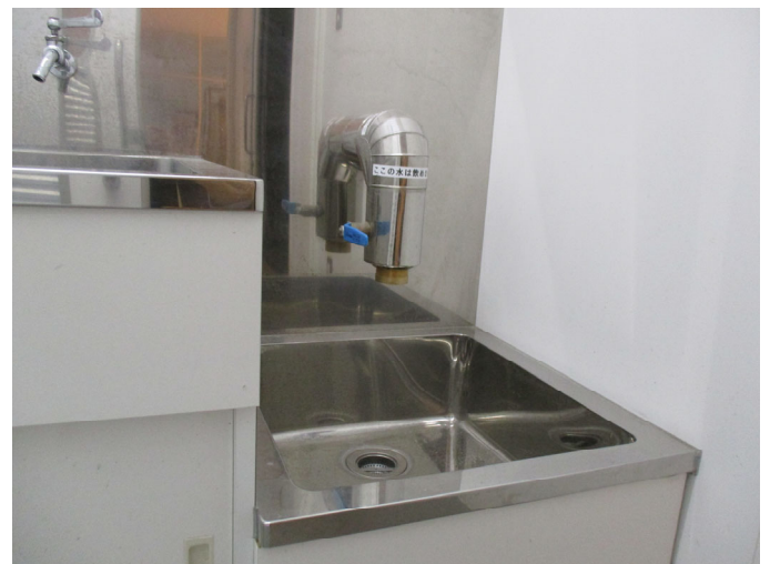
プール水の給水口 (断水時にはトイレの排水に活用できる)
