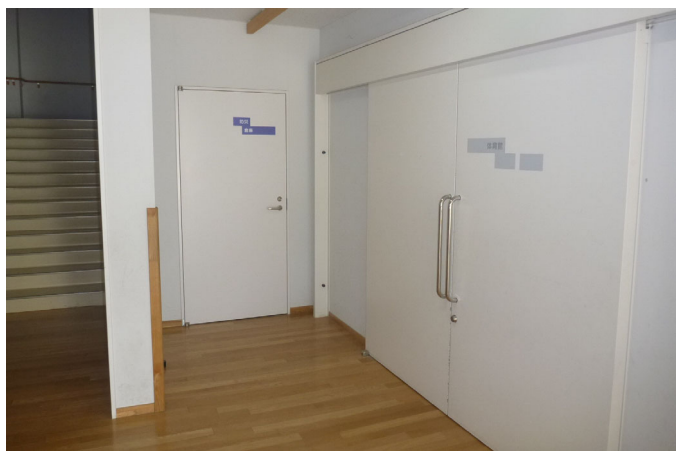
体育館に隣接して設置された防災倉庫
