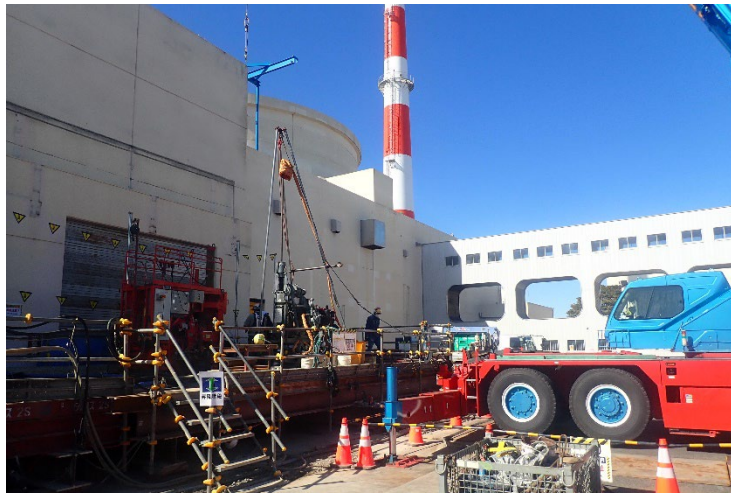
地盤改良の施工状況
