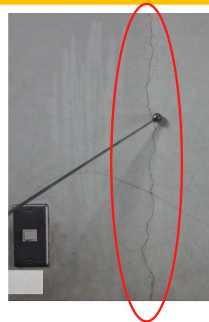
写真5. 内壁のひび割れ
