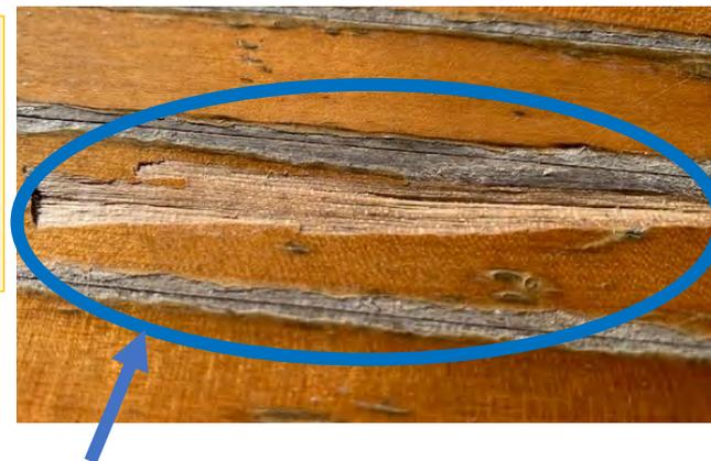
屋内運動場の床の破損（雨漏りが重なり、床が大きく剥がれた）
