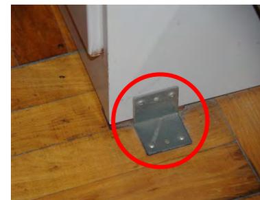
写真2. 棚の下部を床に固定した例
