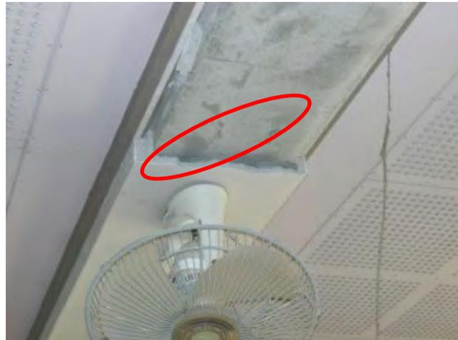
写真4. 梁のモルタルの脱落
