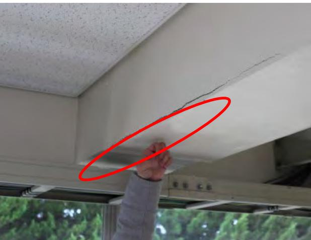
写真3. 梁の仕上げ材のひび割れ
