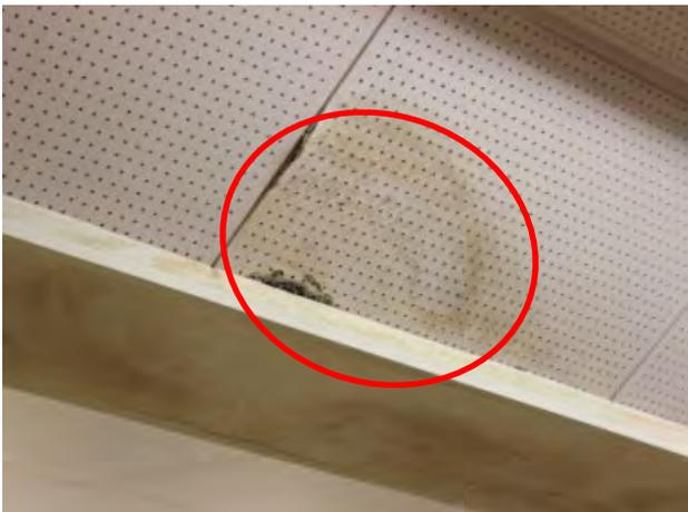
写真1. 天井材のしみ、破損
