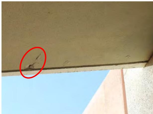
写真2. 階段裏のひび割れ
