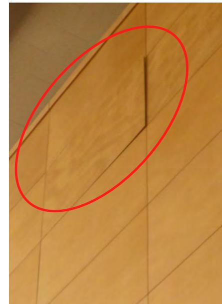
写真6. 内壁のずれ
