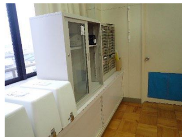
写真2 積み重ねられ 固定されていない棚
