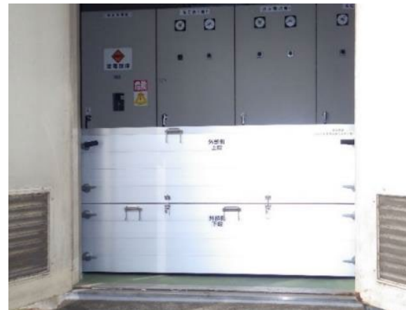
電気室への止水板設置
