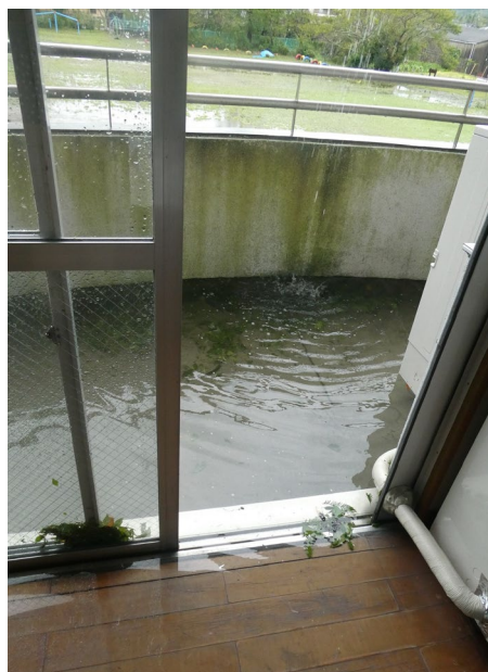
バルコニーからの浸水
