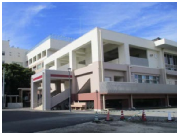
ピロティによる高床化
