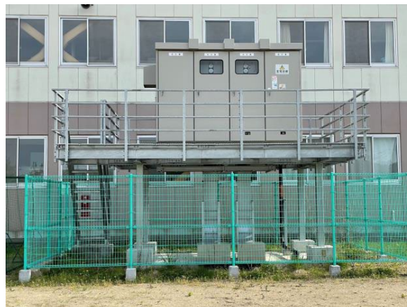
受変電設備のかさ上げ
