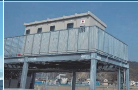
屋外キュービクルのかさ上げ
