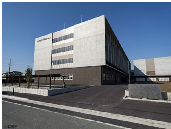
建物と敷地のかさ上げ
