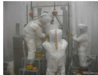
解体作業の様子
