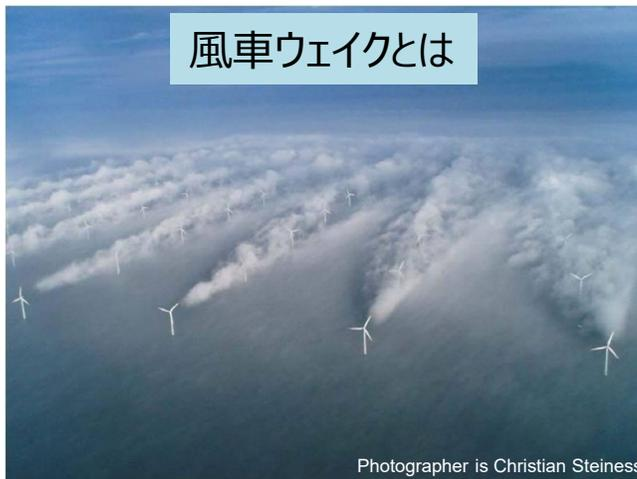
大規模洋上ウィンドファームでの「風車ウェイク」相互干渉の可視化例(出典：C.B. Hasager et al, Wind Farm Wake (2013))
