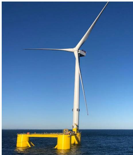
浮体：セミサブ型・鋼製
