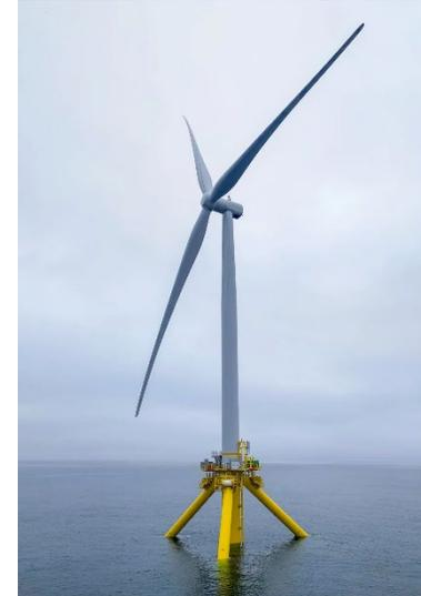
浮体：テトラスパー型・鋼製
