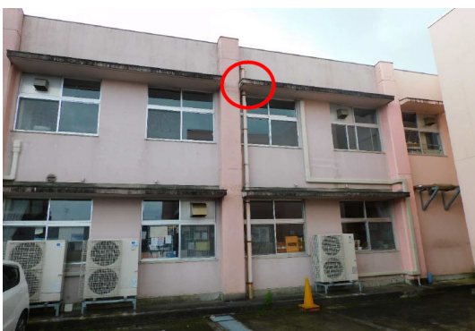
【事例 9】 校舎の 2 階底のコンクリートの一部が落下。
