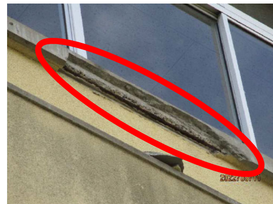
【事例 5】校舎の 2 階窓枠下部外壁のコンクリートの一部が落下。
