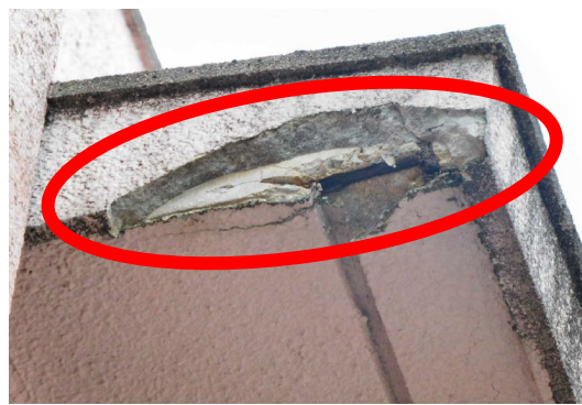
【事例 9】 校舎の 2 階底のコンクリートの一部が落下。
