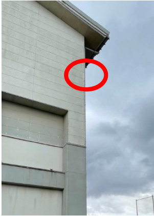
【事例 7】 体育館の外壁のモルタルの一部が落下。
