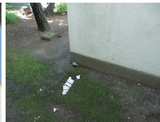
【事例 6】校舎屋上付近の外壁のモルタルの一部が落下。 落下片大きさ：15cm×50cm×1cm（約 1.8 キロ）
