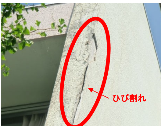
【事例 6】校舎屋上付近の外壁のモルタルの一部が落下。 落下片大きさ：15cm×50cm×1cm（約 1.8 キロ）
