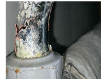
便器配管内に固着した尿石・排水管の腐食、亀裂
