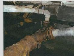
配管が劣化し漏水が発生
