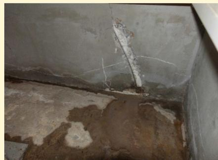
劣化により雨水が浸透している
