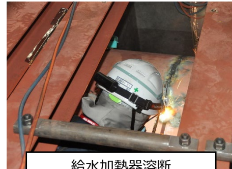
給水加熱器溶断
