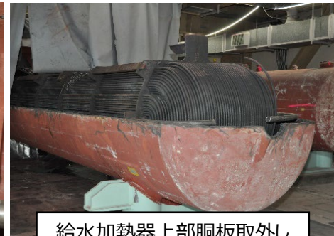
給水加熱器上部胴板取外し
