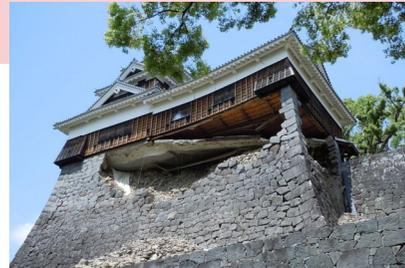
大型地震により石垣が崩壊
